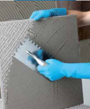
Application du mortier colle sur l'envers du carreau
