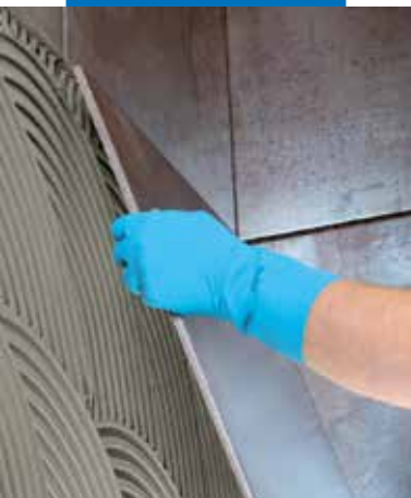
Application de carrelage de grande taille sur un mur
