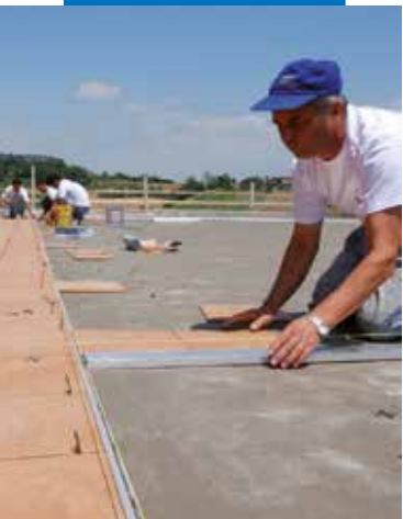
Pose de carrelage avec Kerabond T + Isolastic
