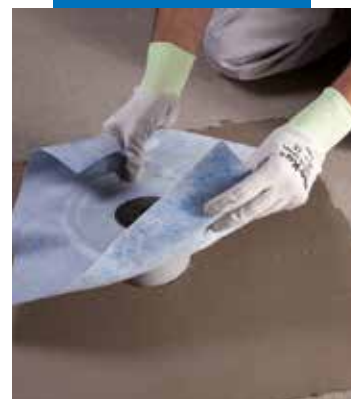
Pose d'un siphon de sol sur Mapelastic
