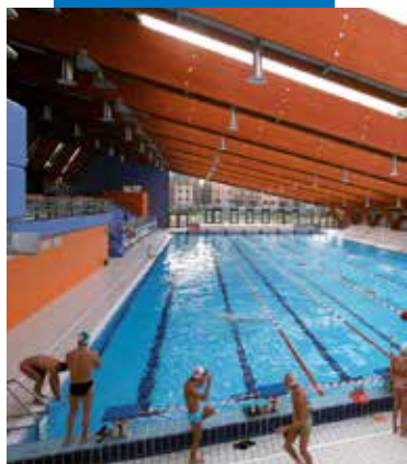
Piscine imperméabilisée avec Mapelastic - Piscine Scarioni - Milan, Italie
