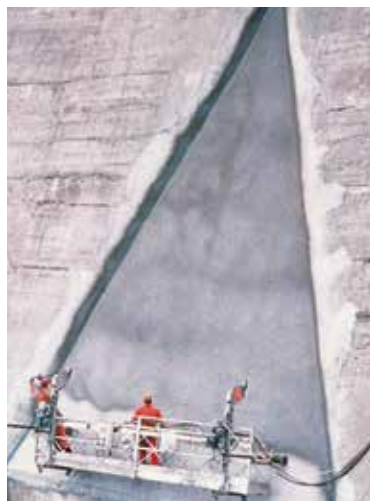
Exemple d'application à la pompe à mortier de Mapelastic sur un barrage
