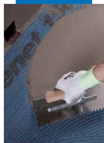
Application d'une couche de Mapelastic sur Mapenet 150
