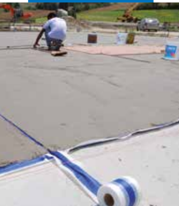
Imperméabilisation des supports avec Mapelastic et Mapeband
