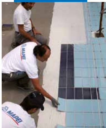
Pose d'un revêtement céramique sur Mapelastic
