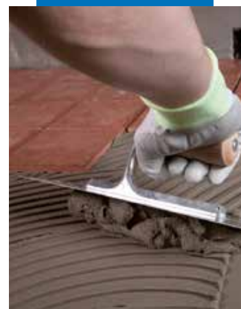
Mise en œuvre de Granirapid sur Mapelastic
