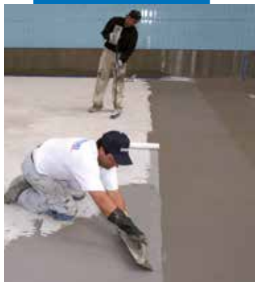
Imperméabilisation d'une piscine avec Mapelastic
