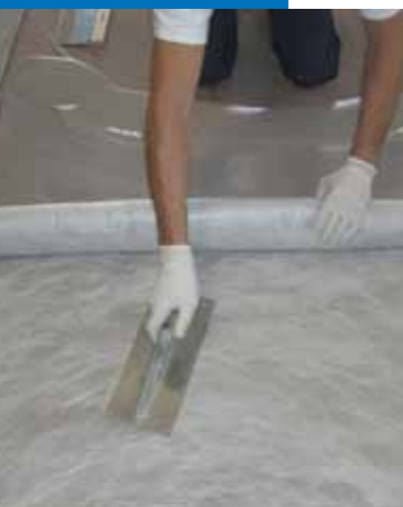
Mise en place de l'armature Mapetex SEL dans la 1 ère passe de Mapelastic Smart
