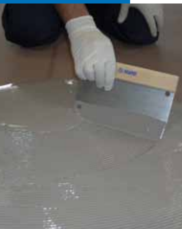
Application de la 1 ère passe de Mapelastic Smart
