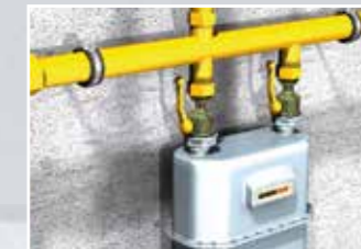
Fixation de compteurs de gaz
