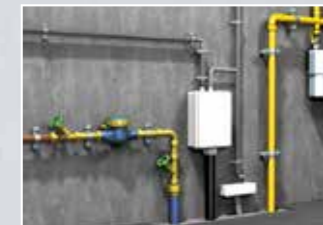
Installation d'appareils sanitaires et de chauffage
