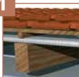
Respecter une lame d'air de 20 mm au minimum de part et d'autre de l'isolant :
