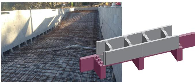
3 - Alphabloc® associé aux blocs de coffrage enduits + ferrailage.
