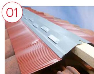
Démarrer la pose du closoir rigide Lahe-Pro Plomb par l'extrémité basse de la lisse d'arêtier (pour le faîtage, commencer par l'extrémité opposé au sens des vents dominants). Bien centrer le closoir sur la lisse.
