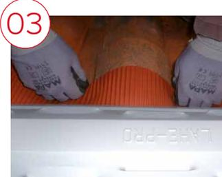
Maroufler manuellement les bavettes du closoir Lahe-Pro Plomb sur le dernier rang de tuiles, du sommet vers le creux d'onde de la tuile. L'espace entre la bavette et le creux de l'onde ne doit pas dépasser 1 cm. Les bavettes doivent recouvrir la tuile de 10 cm (ou 8 cm en creux d'onde pour les tuiles galbées).
