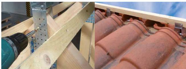
La pose des closoirs en arêtier est réalisée avant celle en faîtage. Le closoir de faîtage devra recouvrir celui de l'arêtier sur toute sa largeur. Le closoir Lahe Pro Plomb doit être adapté à la tuile sur laquelle il sera posé (classe G0, G1, G2 ou G3).
