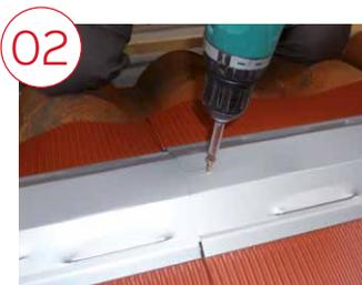
Le recouvrement entre chaque closoir Lahe-Pro Plomb doit être de 5 cm. Les encoches situées à chaque extrémité du closoir permettent de respecter ce recouvrement.
