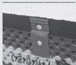
Pour une mise en œuvre de faibles profondeurs (< 3 m), utiliser le trou de fixation haut. Pour des profondeurs plus importantes, la fixation inférieure à travers la nappe DELTA®-MS est à préférer.
