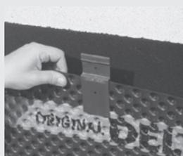
Une autre solution consiste à glisser le Clip dans la nappe avant la fixation mécanique sur le support. Dans ce cas, la fixation sera réalisée à travers le trou inférieur.
