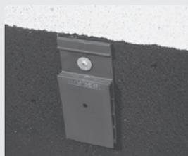
Fixer la pièce au moyen d'une cheville (diamètre 5 mm), de clous avec rondelle, etc. Le point de fixation sera situé env. 2 cm au-dessus du bord supérieur de la nappe à excroissances.
