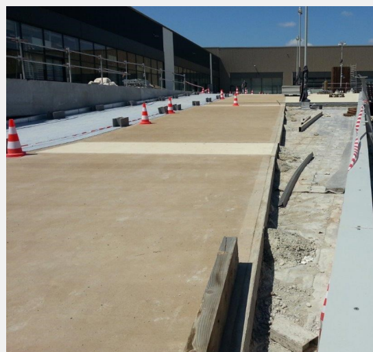
Toitures Terrasses - Centre commercial à Toulouse
