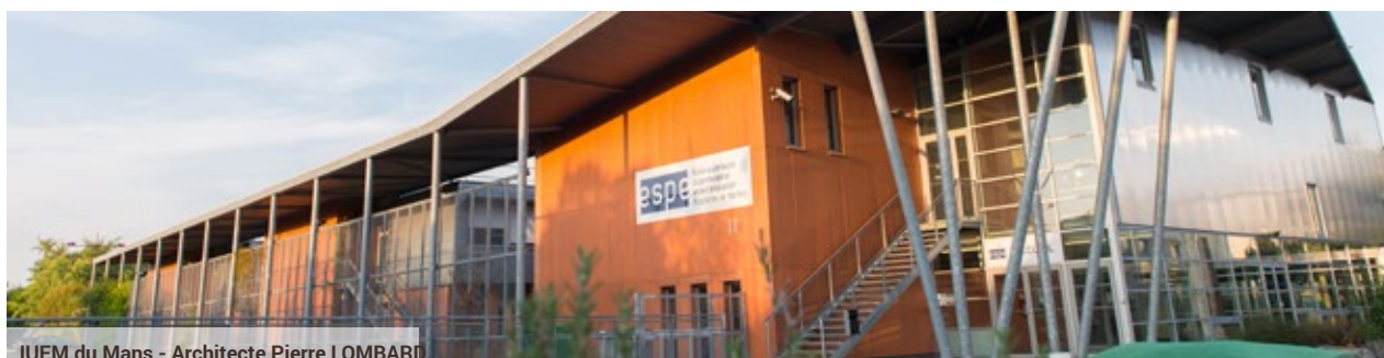
IUFM du Mans - Architecte Pierre LOMBARD
