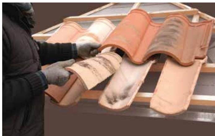
Les couvrements du système sont ensuite installés, en soulevant les tuiles de la première rangée.
