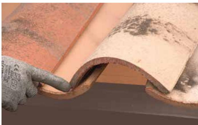
Pour une esthétique parfaite, les nez des couvrements et des courants du système doivent être alignés.
